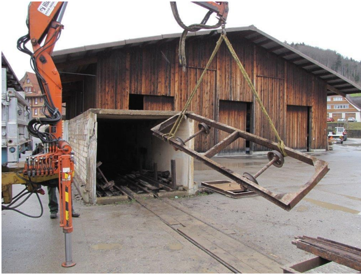
Der Kran vom Saurer erspart uns einiges Bild: Riccardo Keller
