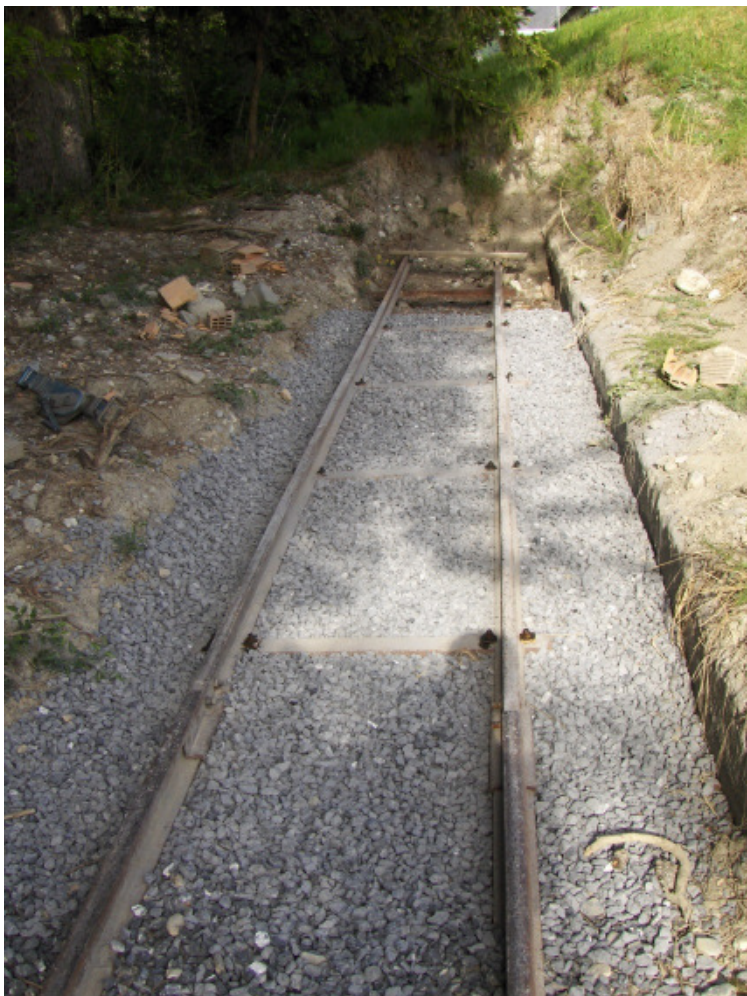
Das frisch geschotterte Gleis Bild: Remo Hartmann
