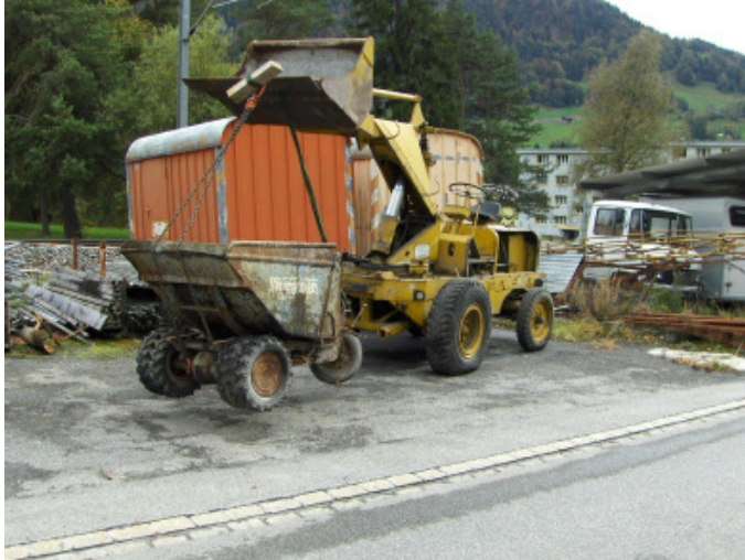
Der Pneu Lader und der kleine Dumper Bild: Remo Hartmann
