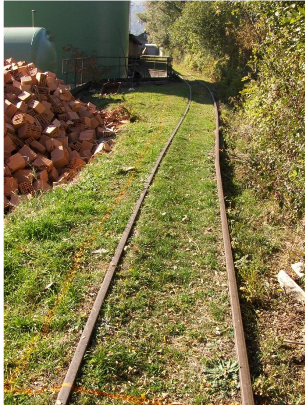
Die Problemstelle ist 30 Meter lang
