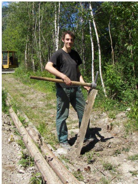
Schwellen ausgraben Bild: Remo Hartmann
