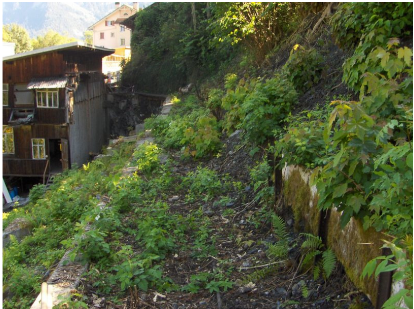
Aus diesem Dreck galt es das Gleis zu befreien (Bild: Remo)
