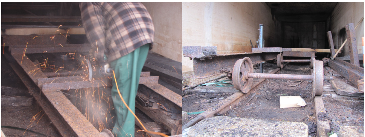
Die erste Metalllore setzt sich der Trennscheibe zur Wehr...erfolglos: Game over
