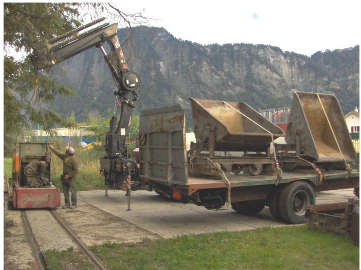
Scaricando i vagonetti e caricando la locomotiva
